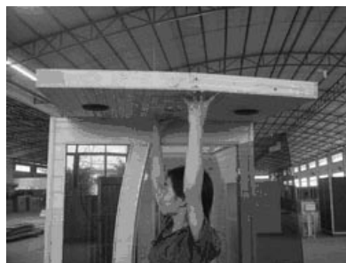
OBR-10 Montáž horní desky
