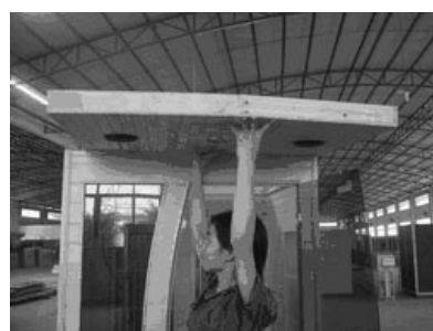
OBR-10 Montáž hornej dosky
