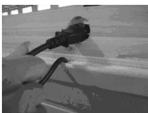
OBR-11 Privedenie drôtov z ohrievacích telies na platňu a ich pretiahnutie vhodným otvorom.
