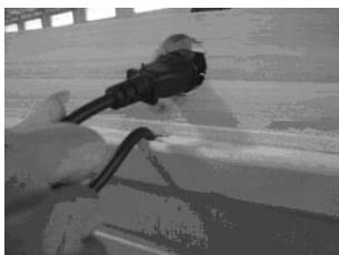
OBR-11 Přivedení drátů z ohřívacích těles na desku a jejich protažení vhodným otvorem.
