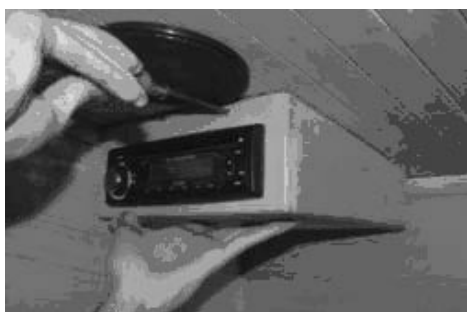
OBR-18 Priskrutkovanie zadného krytu CD prehrávača
