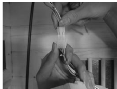
OBR-17 Pripojenie konektorov k ovládaciemu panelu
